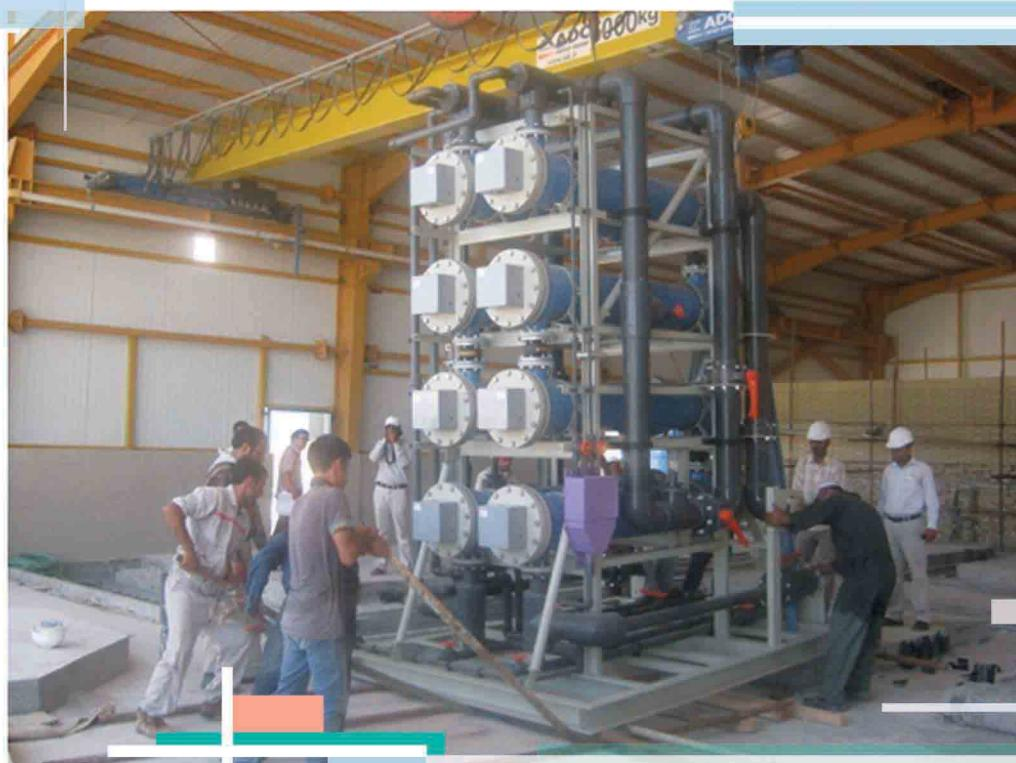
این سیستم جهت تامین کلر جبکت تزریق به ساکشن چمبر ها ، داخل آبگیر ، پمپ ها و ... طراحی و تامین می گردد. پکیج کلراسيون دارای قطعات و تجهیزات کوچکتری از جمله فیلترها ، مبدل ها ، الکترولایزرها ، سیستم اسید شویی ، سیستم جداکننده هیدروژن و ... می باشد .
