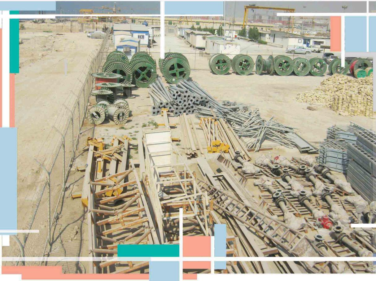
در بتن ریزی حجمی پلان جانمایی کارگاه باید پشكل مناسب تعیین گردد. مسیرهای تردد ماشین آلات بتن باید بشکلی باشد که خلی در روند اجرایی سایر فعالیتهای کارگاه ایجاد ننماید. با توجه به تعداد زیاد ماشین آلات نظیر تراک میکسر باید فضای کافی جهت پارکینگ در نظر گرفته شود.
