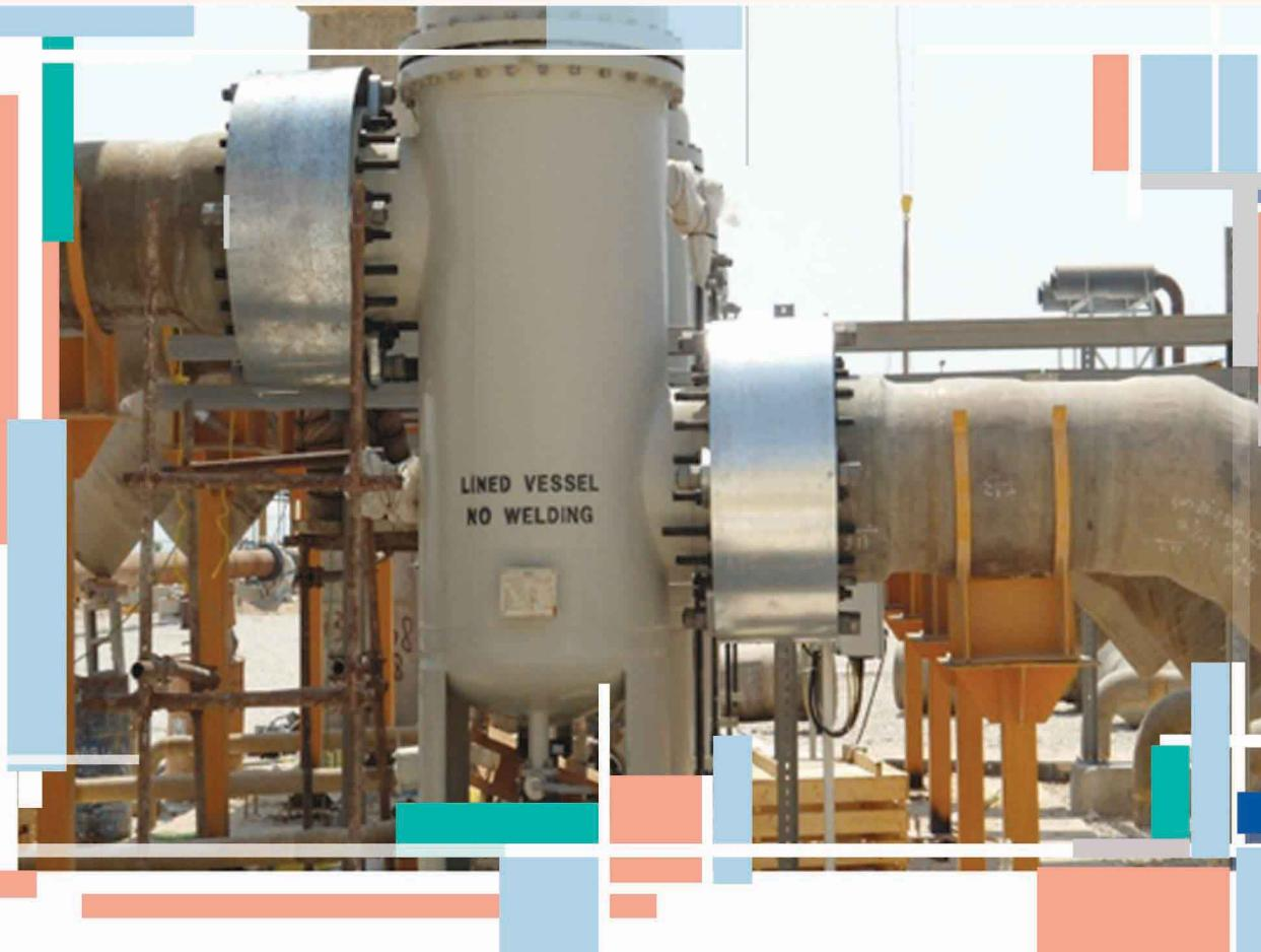
جهت تصفیه نهایی آب خارج شده از آبگیر ( که معمولاً تا ۲ میلیمتر تصفیه فیزیکی شده اند ) از تعدادی اتوفیلتر استفاده می شود . معمولاً اتوفیلتر ها آب را تا ۵۰۰ میکرون تصفیه می کنند . و پس از تصفیه نهایی توسط این تجهیزات آب جهت تصفیه شیمیایی به سیستم های حرارتی و یا RO منتقل می شود .
