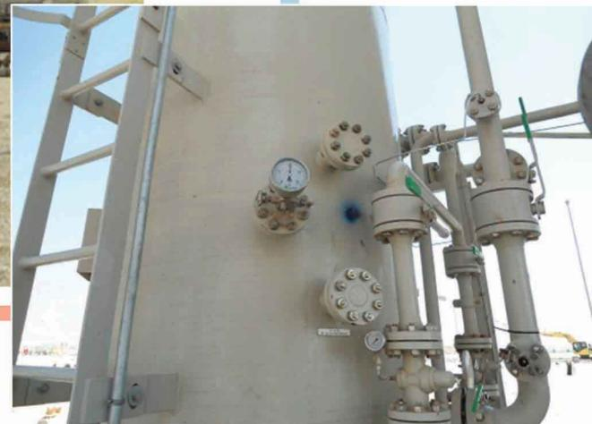
این مخازن به منظور جلوگیری از ایجاد خرابی های ناشی از ضربه قوچ و دمپ نمودن موج فشاری ناشی از آن مورد استفاده قرار می گیرد
