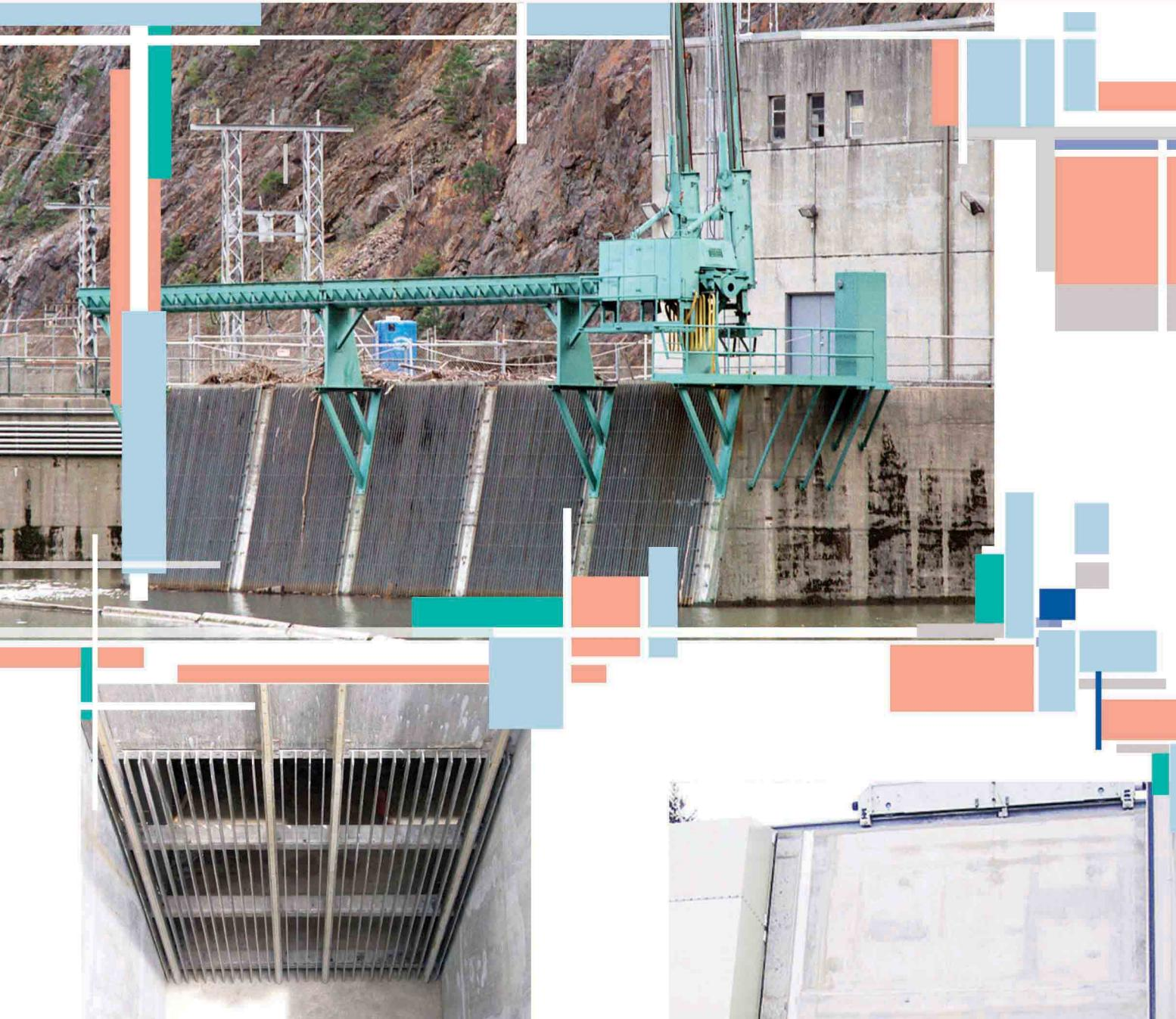
باراسکرین جبتو از ورود زباله و ذرات بیش از ۲ سانتیمتریه صورت یک سازه فلزی که از جنس استیل ضد زنگ می باشد ساخته می شود. مناسب با مشخصات فنی ارائه شده از سوی کارفرما فاصله و ابعاد بارها می تواند متفاوت باشد.
