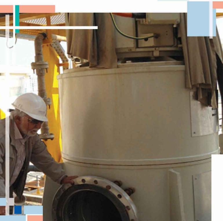
به منظور پمپاژ آب دریا به داخل آبگیر از تعدادی مشخص (که به ظرفیت مورد نیاز آب تصفیه شده بستگی دارد) پمپ اصلی استفاده می شود . در مکش هر پمپ یک لوله ۲ اینچ کلراسیون به منظور گند زدایی آب دریا قرار دارد.
