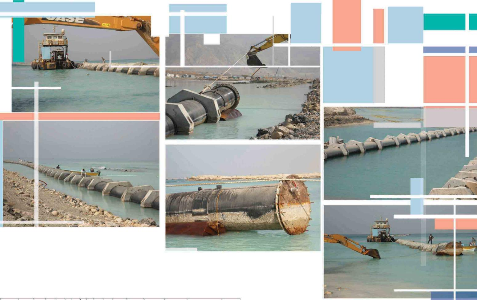
به منظور ورود آب دریا به داخل آبگیر خط لوله های با طول و قطر مشخص احداث می شوند.
