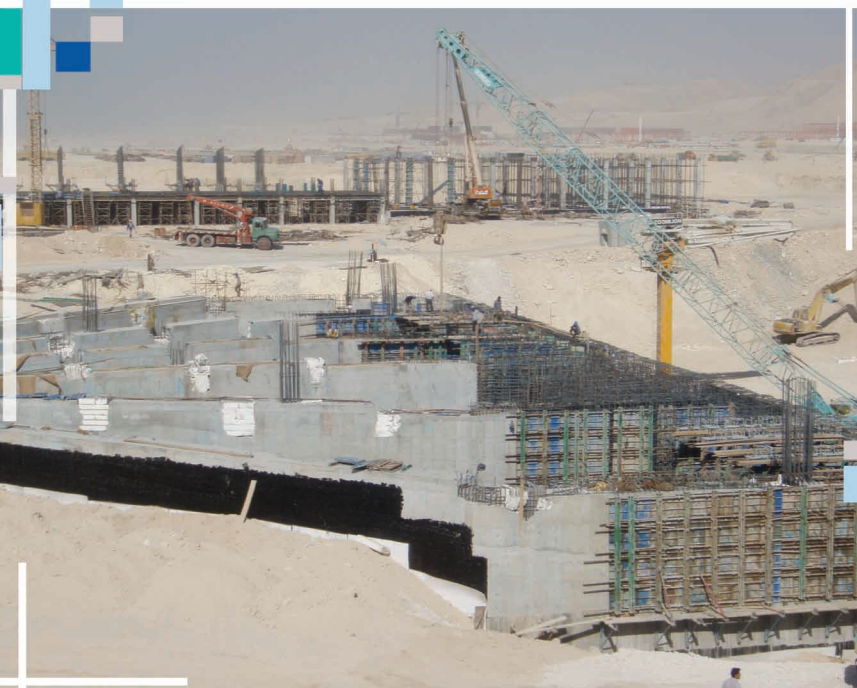
تصاویری از نحوه آرماتوربندی ، قالب گذاری و بتن ریزی در مقیاس حجیم نمایش داده شده است.
